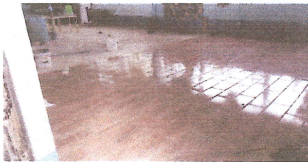
Foto 2: instalación del piso cerámico dentro de las aulas.
