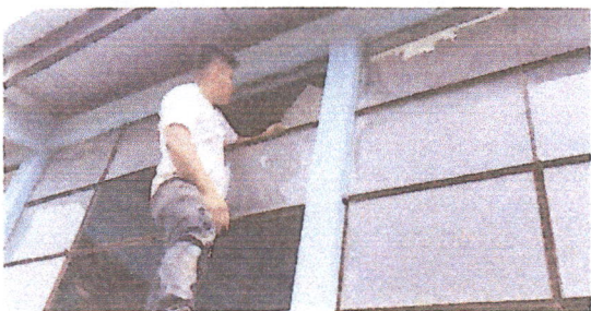
Foto 3: Se observa la reparación de los vidrios rotos y en mal estado.
