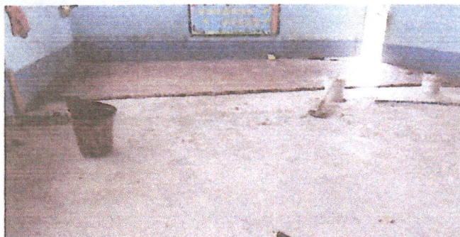
Foto1: Se observa en proceso la instalación del piso cerámico dentro de las aulas del centro educativo
