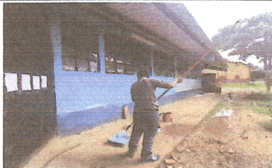
Foto 5: Se observa el momento de la aplicación de la pintura en los módulos intervenidos en la parte exterior.
